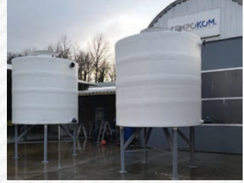
SEYİT ÖMER TERMİK SANTRALİ ÇELİKLER HOLDİNG KÜTAHYA
