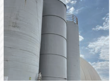
ITC ESKİŞEHİR KATI ATIK ENTEĞRE TESİSİ ITC-KA ENERJİ ÜRETİM ESKİŞEHİR
