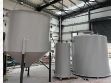
FOÇA BİYOGAZ ENERJİ SANTRALİ ENERGROM ENERJİ TİC. VE SAN. A.Ş. İZMİR
